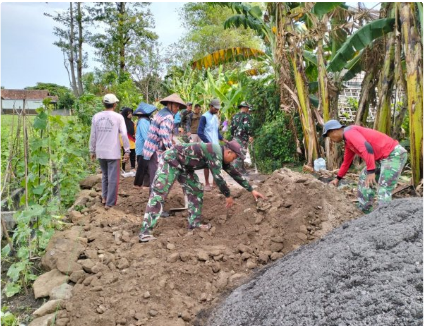
Peduli Jalan Rusak Di Wilayah Binaan, Babinsa Bersama Warga Karya Bakti Timbun Jalan.
